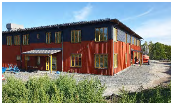
Slutskedet av byggnation av Lindhallen
