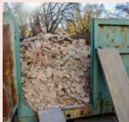
Närmare 14 ton tegel har bytts ut i kremationsugnen.
