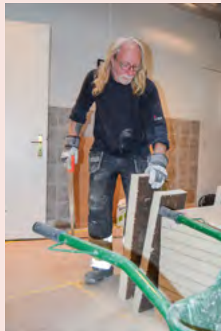
Jan Öhman sågar till isolering som ska monteras i ugnen.
