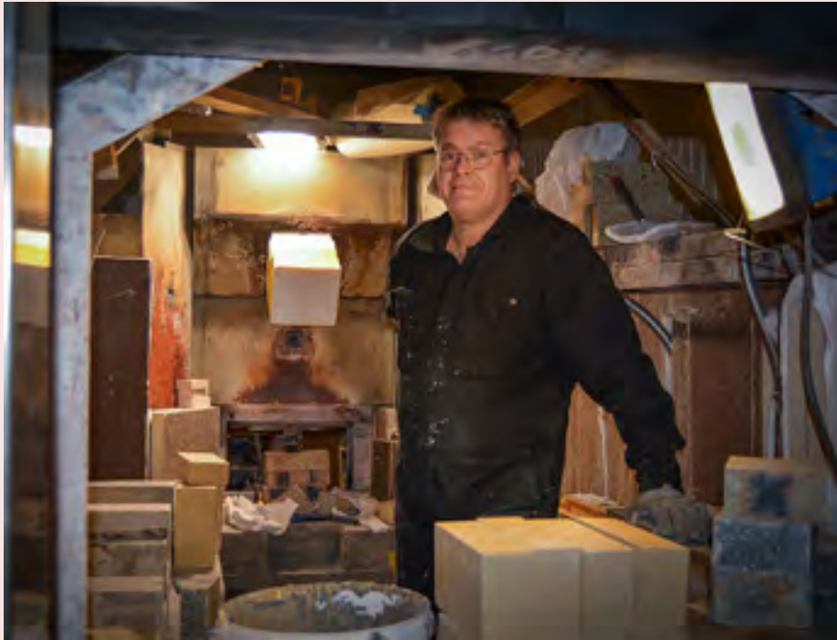
Ulf Dalén har rivit bort det gamla teglet ur kremationsugnen och sätter i ny isolering och murar upp nya innerväggar med hjälp av nytt tegel.
