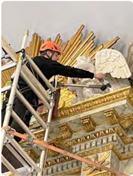
Erik både dammsuger och använder en fin borste när han rengör listerna.
