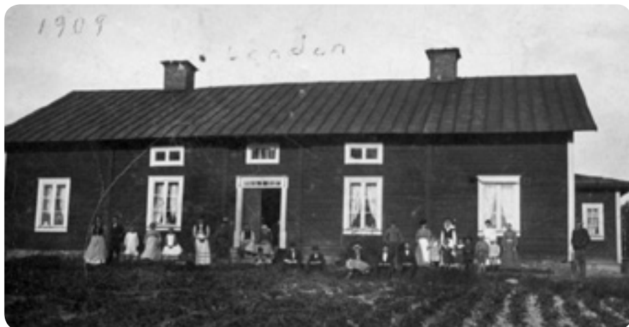
London var från början benämningen på en gruvarbetarbostad som uppfördes i Meling på 1870-talet med 8 rum på nedre botten och 4 rum på övre. Se länk Källa: www.bygdeband.se/?posttype=attachemnet&p=514731
