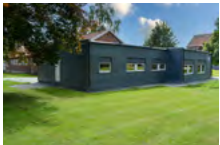
2017 fick Lindgårdsskolans högstadium NO-sal och ett extra klassrum i en modul bakom den långa tegelbyggnaden på Sturevägen.
