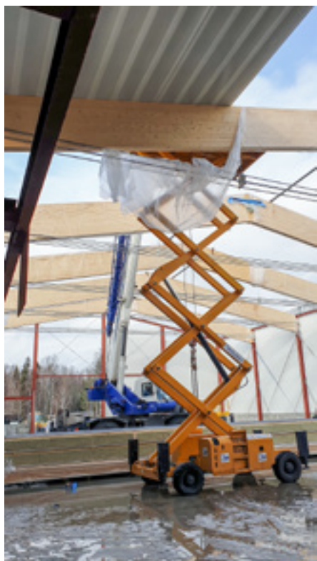
Takstolarna är på plats och taket ska läggas på.
