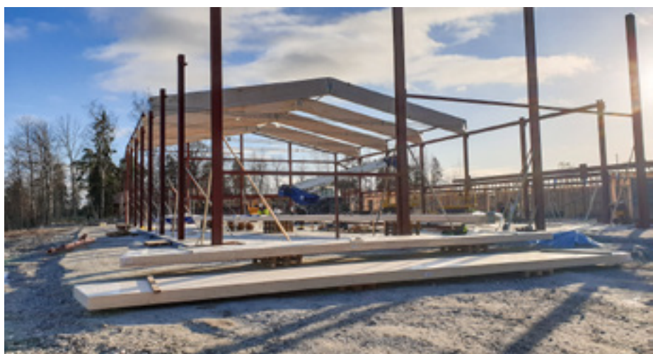
Takstolarna är på plats och taket ska läggas på.
