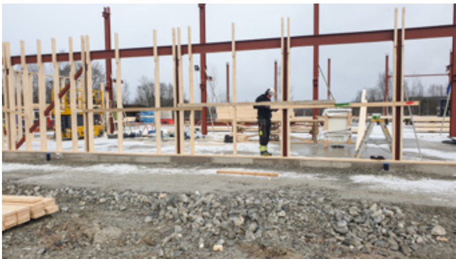
Innerväggar monteras.
