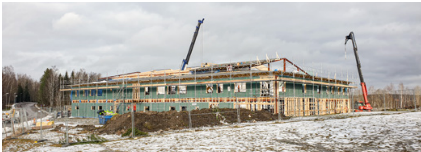
Byggnaden börjar ta form både utvändigt och invändigt...
