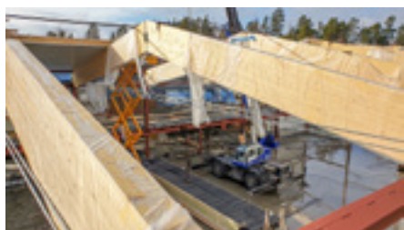
Takstolarna är på plats och taket ska läggas på.
