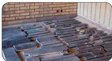
På vissa ställen lagas stengolv med bitar från det gamla golvet.
