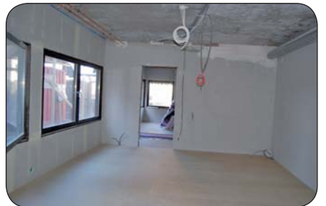
På nedre plan är det flesta väggarna färdigmålade och golven är spacklade. Nästa steg blir att montera innertaket.
