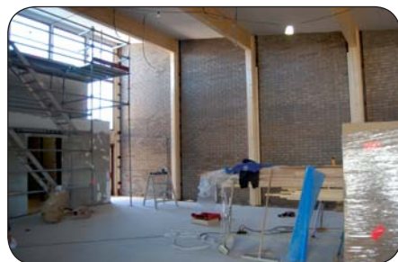
I det stora rummet Hjortronmyren är nya limträbalkar monterade. Takhöjden blir samma som förut med fönster högt upp mot husets framsida.
