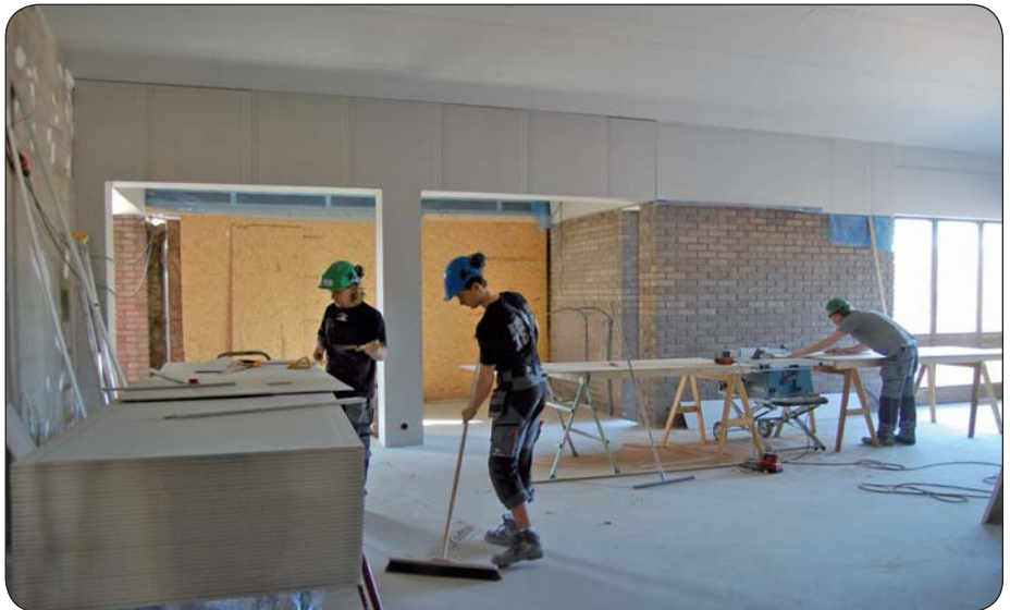
Byggjobbarna har nu gjort färdigt innertaket i matsalen Smultronstället och det ska spikas panel på väggarna. Golvet åtgärdas sist.
