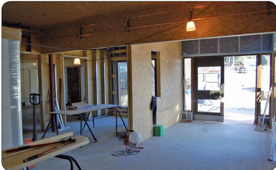
Byggnationen pågår av den nya entrén med reception.
