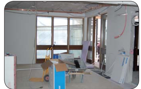
Byggjobbarna har nu gjort färdigt innertaket i matsalen Smultronstället och det ska spikas panel på väggarna. Golvet åtgärdas sist.
