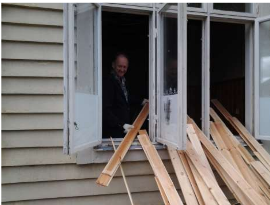
Renovering och ombyggnation av gamla klockarskolan till musikhus
