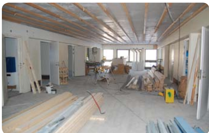
Församlingsexpeditionen återställs och yttertaket blir nytt.
