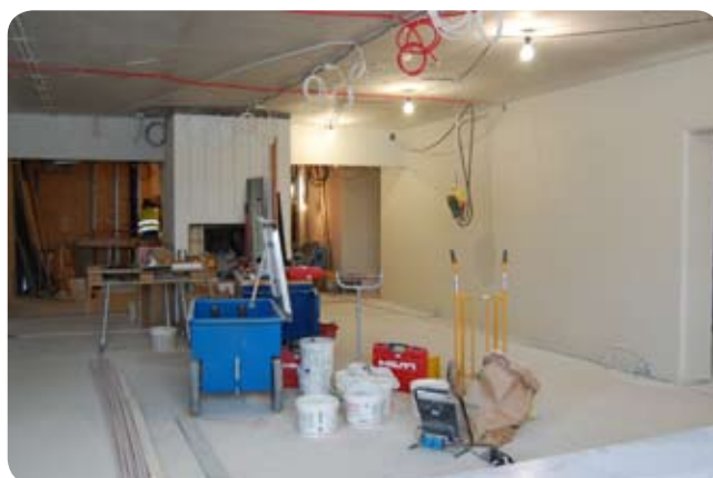
På nedervåningen pågår målning av väggar.
