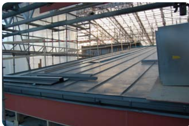
Ett nytt tak är på plats under det väderskyddande tältet som kommer att tas bort efter årsskiftet.
